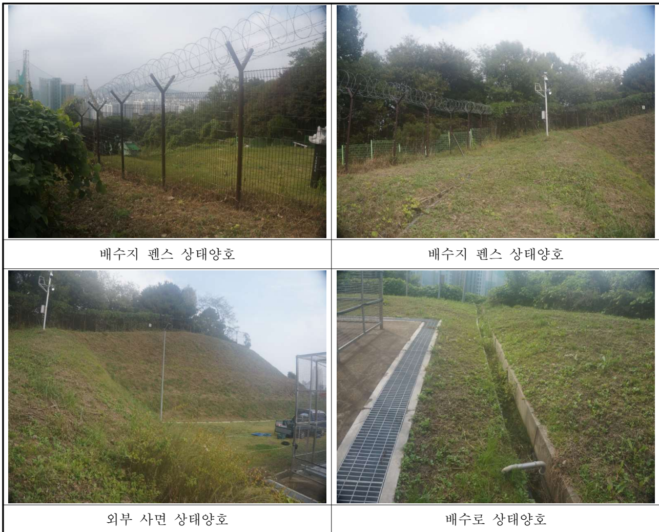
【사진 3.8】 기타 부대시설 손상사진
