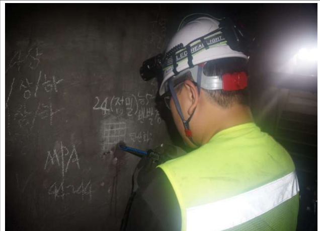
탄산화 깊이 측정
