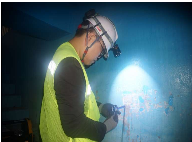
탄산화 깊이 측정
