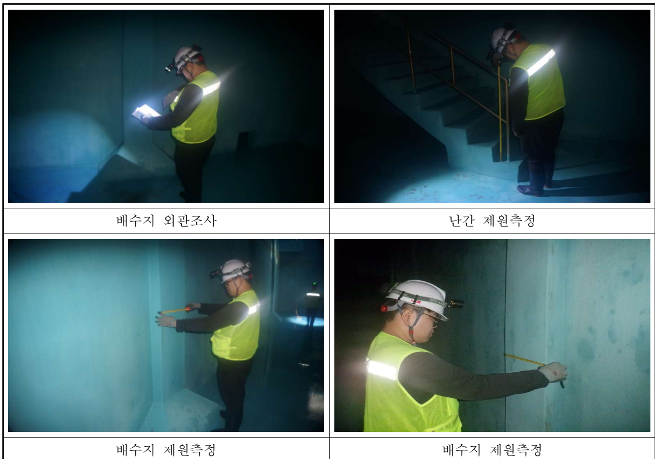
【사진 3.1】 시설물 외관조사
